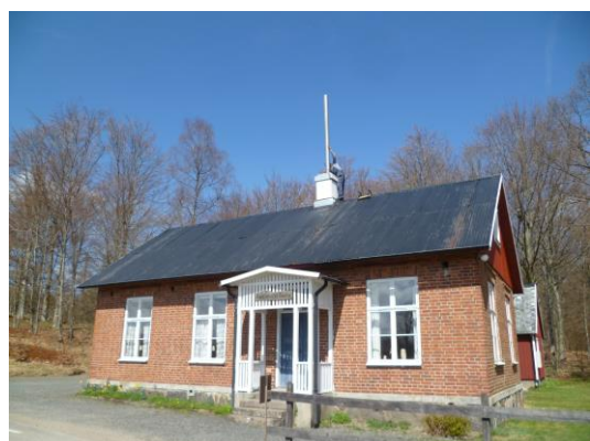
Den stora skorstensrenoveringen utfördes den 2 maj.
