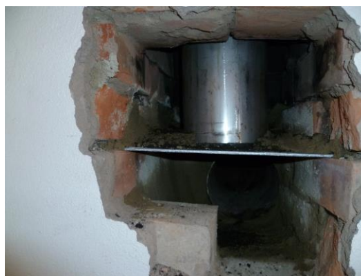
Här är nya rökkanalen sedd inifrån hallen.
